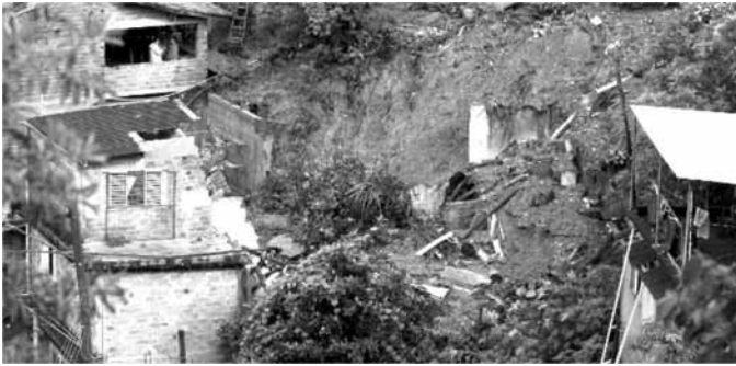
DESLIZAMENTO DE TERRA NA GRANDE SÃO PAULO
