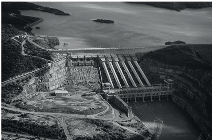
Localizada entre Alagoas e Sergipe, a Usina Hidrelétrica de Xingó é operada a fio d'água – o mesmo volume que entra nela, acaba saindo. Com capacidade de armazenamento de 3,8 trilhões de litros em seu reservatório, Xingó tem uma potência instalada de 3.162MW. A hidrelétrica está entre os municípios de Piaçabuçu (AL) e Brejo Grande (SE).
